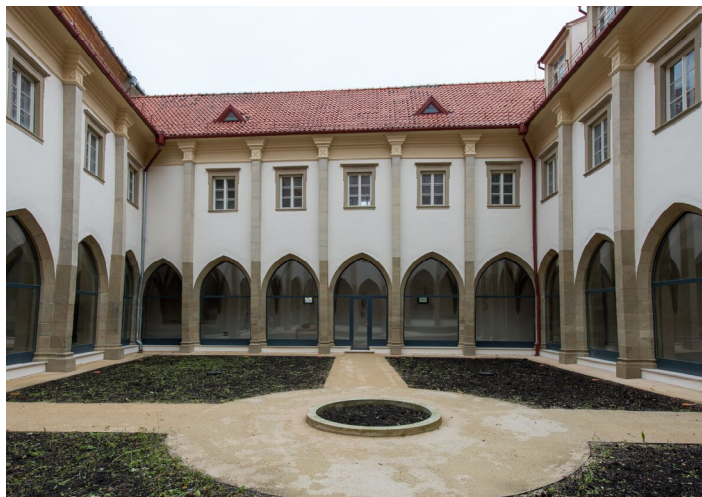
Kláštor minoritov v Levoči, átrium po obnove
